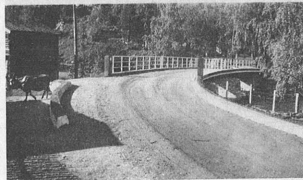
Ombygging av Tessa bru. Den provisoriske bru sees tilhøira på øverste billede. Nederst den nye bru.
